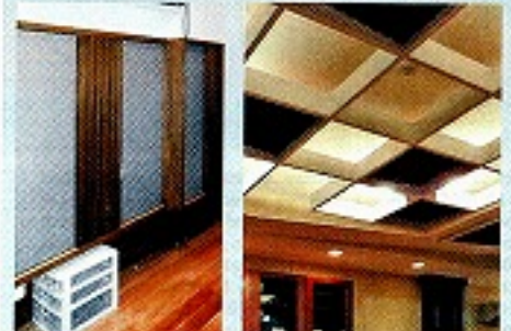
Le traitement acoustique de la salle, des murs et du plafond (voir photo) a une importance capitale sur la restitution fidèle hautement musicale avec une grande intelligibilité.
