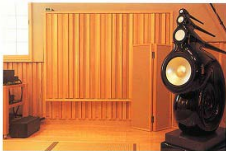
木格子と可動吸音バネで音場コントロールを行う。バスレフの位置はネット・フロント・トライである。
